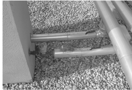
Figura 2.2. Canonada amb aïllament i protecció de l'aïllament.
